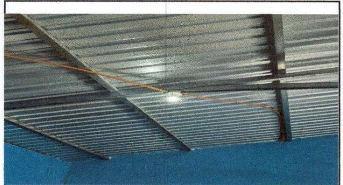
Foto 8: Reparación de sistema eléctrico, en dos aulas del módulo 1 y dirección del establecimiento.
