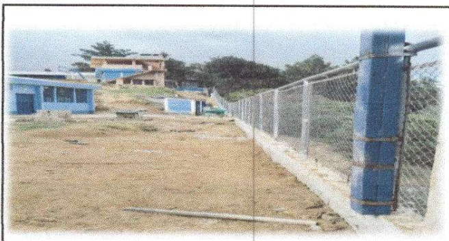
Foto 6: Reparación de muro perimetral de block, en exterior del módulo 2.
