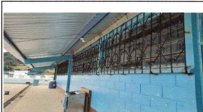
Foto 9: Fabricación e instalación de balcones de hierro en ventanas, frente a dos aulas del módulo 1 y en 3 ventanas de la dirección.
