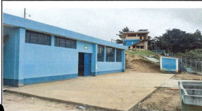
Foto7: Losa de patio, frente a la cocina escolar del módulo 2
