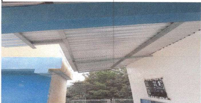
Foto 2: Sustitución de estructura de soporte de madera, por metal, en la dirección del establecimiento.
